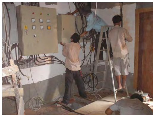
Installer à Battambang les armoires et câbles pour un hôtel et des bâtiments privés
